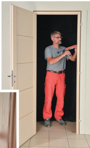
Appliquer un joint de silicone au pourtour du bloc porte entre l' huisserie et le jeu de réservation de la cloison, coté opposé aux équerres de fixation. (Silicone non fourni).
