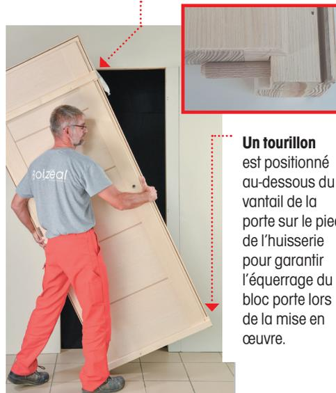
Un tourillon est positionné au-dessous du vantail de la porte sur le pied de l'huissierie pour garantir l'équerrage du bloc porte lors de la mise en œuvre.
